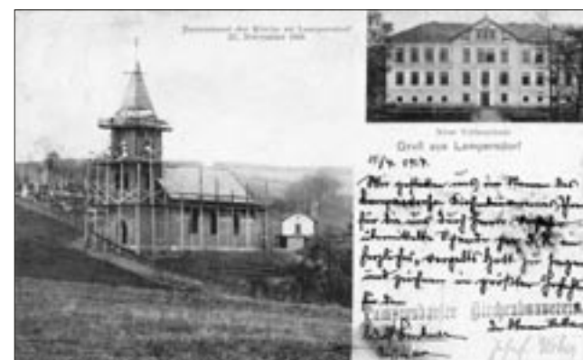
Pohlednice z 22. 11. 1906 ukazuje stavební stav nového kostela v Lamperticích
