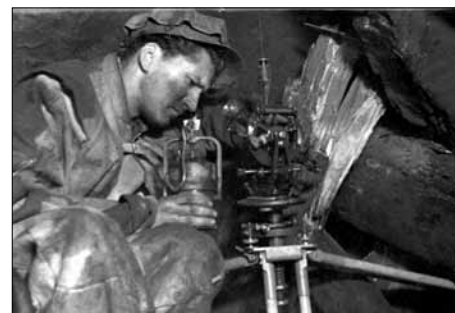
Jiří Duška si posvítil na teodolit, aby přečetl naměřené hodnoty.
