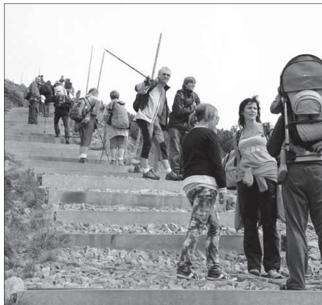
Na konci osmdesátých let byla cesta na Sněžku od Růžové hory jednou širokou erozní brázdou. Velká zátěž přinutila Správu KRMAP po dvaadvaceti letech od zpevnění letos provést nové štětování kvalitním kamenem dopraveným nahoru vrtulníkem. Snížení nezbytných stupňů přispěje k pohodlnější chůzi turistů hlavně při sestupu.
