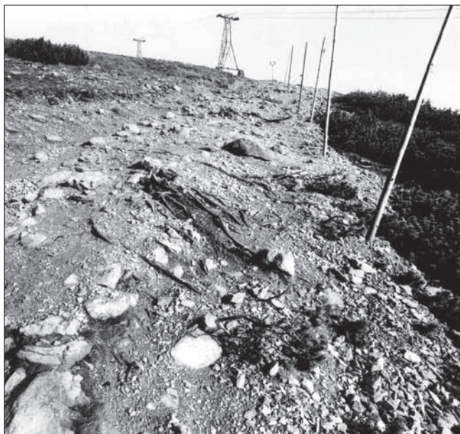
Na konci osmdesátých let byla cesta na Sněžku od Růžové hory jednou širokou erozní brázdou. Velká zátěž přinutila Správu KRMAP po dvaadvaceti letech od zpevnění letos provést nové štětování kvalitním kamenem dopraveným nahoru vrtulníkem. Snížení nezbytných stupňů přispěje k pohodlnější chůzi turistů hlavně při sestupu.
