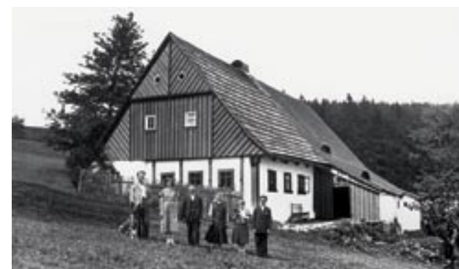
7.8 Chalupy – deskowanie ściany szczytowej, Žacléř – Rýchory nr. 6, 1934 r.
