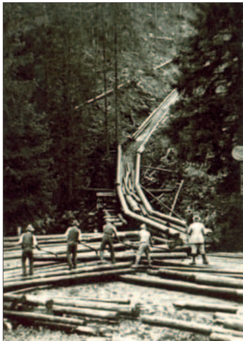
Autor nieznany 1931: Spuszczanie drewna po skluzach w Temnym Dole, redakcji VV udostępniła rodzina Rummler 2009.
