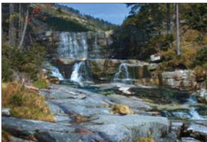
Regulace Čertovy strouhy ve Špindlerově Mlýně
