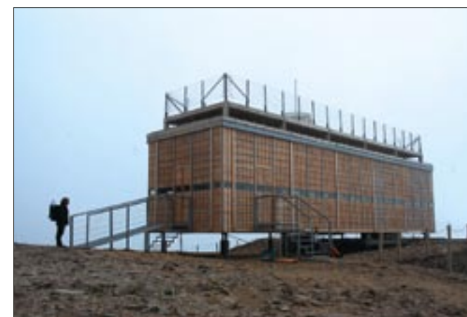
Otvíráním a zavíráním hydraulicky ovládaných žaluzií se mění podoba nové České poštovny. Stejným způsobem je prosvětlený i spodní dům ukrytý pod zemí v místě někdejšího sklepa České boudy.
