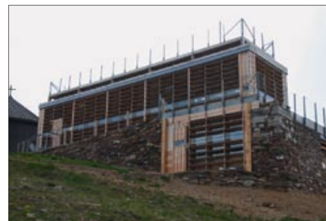
Otvíráním a zavíráním hydraulicky ovládaných žaluzií se mění podoba nové České poštovny. Stejným způsobem je prosvětlený i spodní dům ukrytý pod zemí v místě někdejšího sklepa České boudy.
