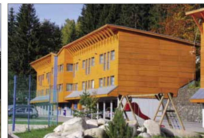
Pensiony v areálu Aquaparku ve Špindlerově Mlýně s pultovou střechou, 2005.
