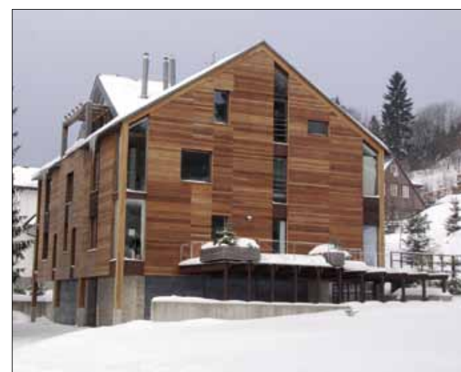
Rekreační bytový dům ve Špindlerově Mlýně s nosnými dřevěnými sloupy, 2005.
