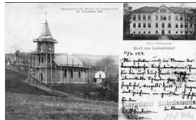
Pocztówka z 22.11.1906 pokazuje stan zaawansowania budowy nowego kościoła w Lamperticach
