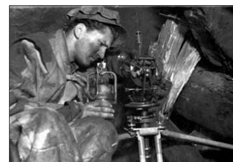
Jiří Duška świeci na teodolit, by móc odczytać wyniki pomiarów.
