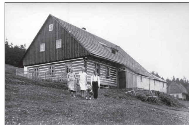
Śnieżne domki nr 39, wybudowano po pożarze w 1924 r., zburzone w 1960 r., gospodyni Marie Zieris *1880 na Klinowych budach (stoi po lewej stronie).
