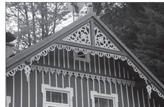
Ozdobna ściana szczytowa chałupy VÚ 1 nr 214 wybudowanej chyba w 1913 r., zdjęcie z 2008 r.
