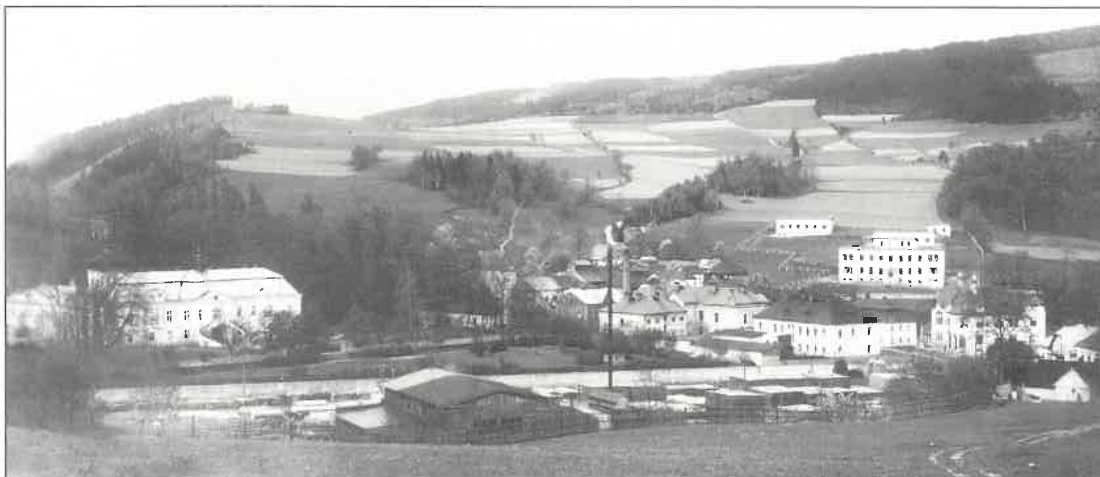
Stavební ruch v letech 1898 až 1908 přinesl do centra Maršova přestavbu zámku, novou pilu, budovu okresního soudu, obecní dům s kašnou, nemocnici a další domy. Foto W. Lahmer, 1908.
