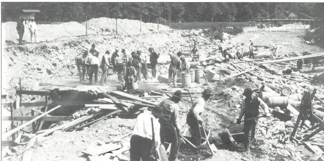
Pohled z dnešního Modrého mostu zachycuje stavbu regulačních zdí u obecního úřadu v roce 1902. Foto W. Lahmer.
