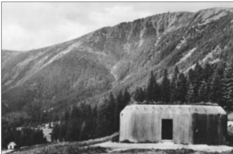
Zcela dokončený bunkr řopík u kapličky v Obřím dole zachycuje propagandistická německá pohlednice vydaná brzy po záboru Sudet v roce 1938.
