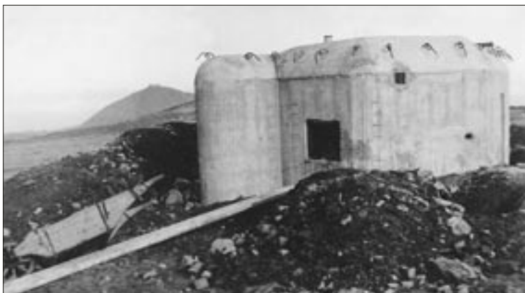
Narychlo opuštěné staveniště bunkru na Luční hoře v říjnu 1938.
