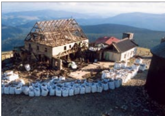
Původní tvar boudy z roku 1868 byl nejvíce patrný 7. října. Vybouraný materiál naplnil přes 350 přepravních vaků
