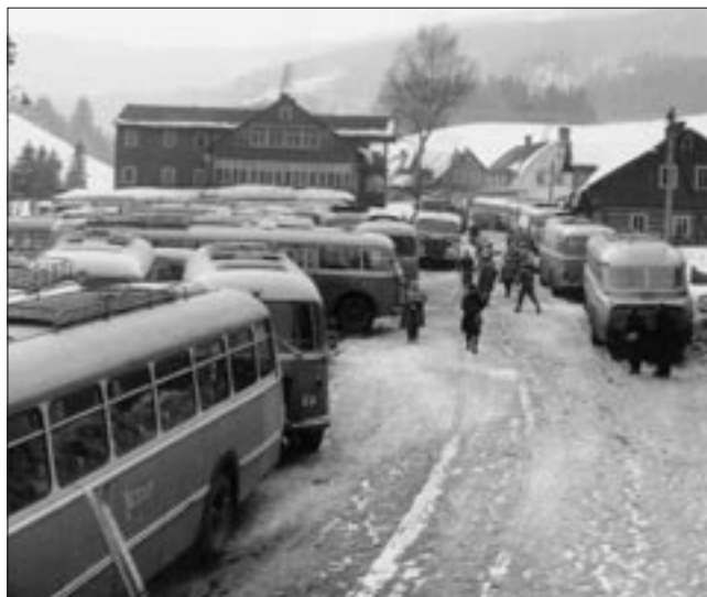
Snímek Hlavní ulice ze začátku 60. let, kdy hosté do Pece přijížděli většinou autobusy, připomíná jak v úzkém údolí řeky Úpy a Zeleného potoka bylo bez velkých parkovišť těsně. Nyní při respektování pravidel, především odstavných vozidel pouze na vyhrazených parkovištích, zůstávají silnice průjezdné. Hosté se dostanou k cíli, skibusy k lyžařským vlečům, sanitky pro zraněné lyžaře a nic nebrání uklízení sněhu. Pro jistotu na parkování dohlíží přísná Městská policie.
