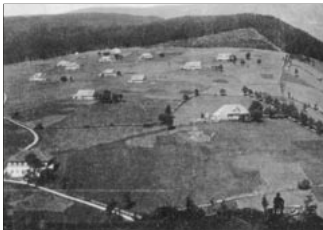
Velká Pláň v roce 1908, jen úřední budovy škola a lesní správa měly valbovou střechou
