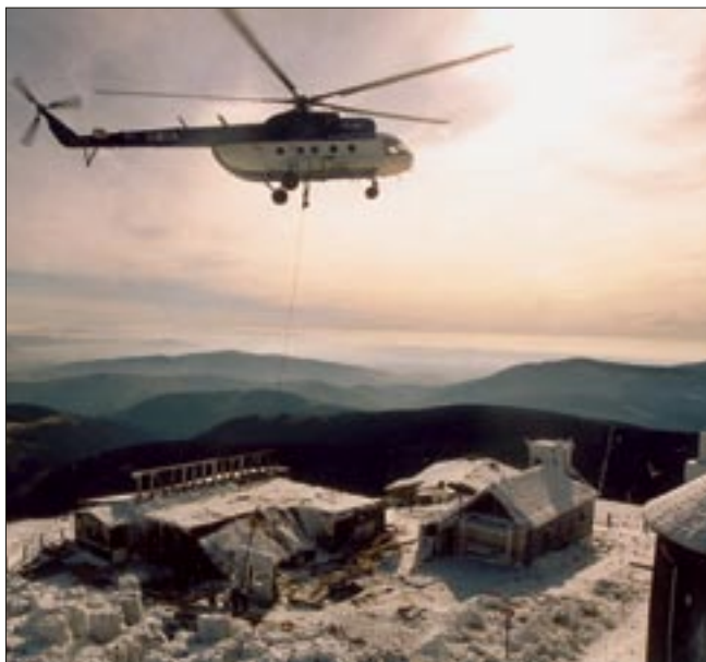
Hlavní část České boudy snesl do Lviho dolu vrtulník 20. října. Odlétla i nádrž na 3200 litrů vody čerpané sem v letech 1912 až 1956 z Obřího dolu pomocí Peltonova kola
