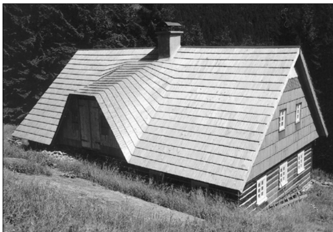
Oživení vzácného seníkového vikýře šindelem na Tonových domcích (1992 - 2003)
