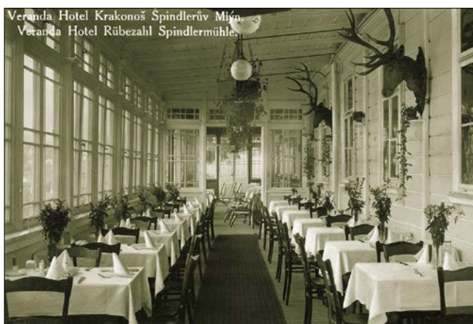
Veranda hotelu Krakonoš ve Špindlerově Mlýně - lovecké trofeje, koberec běhoun, stříbrné přístroje, živé i řezané květiny (1929)
