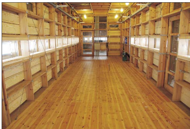
Úplné dokončení pláště po administrativním zdržení nedovolila začátkem listopadu námraza, přesto byla stavba do konce roku 2007 připravena k předání. K zateplení slouží vnitřní sklápěcí izolační panely.
