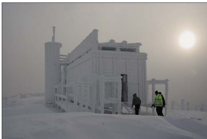
Úplné dokončení pláště po administrativním zdržení nedovolila začátkem listopadu námraza, přesto byla stavba do konce roku 2007 připravena k předání. K zateplení slouží vnitřní sklápěcí izolační panely.
