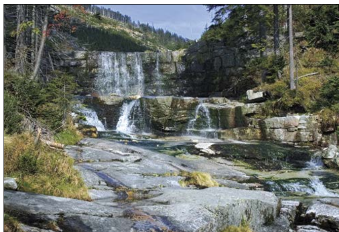
Regulace Čertovy strouhy ve Špindlerově Mlýně
