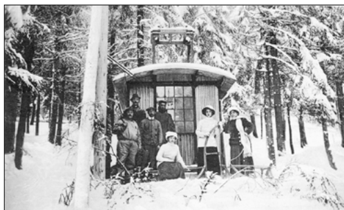
Právě dokončená horní stanice sáňkařského výtahu, 1913
