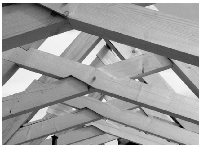
Pohledová tesařská konstrukce přístavby boudy Jelenka v Malé Úpě.
