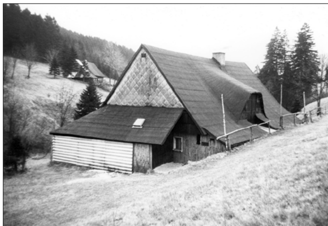
Chalupu s maloúpským seníkovým vikýřem čp. 49 v Dolní Malé Úpě jsem poprvé fotografoval 6. prosince 1986. Již tehdy jsem tušil, že představuje unikátní prvek lidové architektury. Škoda, že právě na této chalupě majitel vikýř později zbořil, dodnes se na celém světě zachovalo jen šestnáct posledních.
