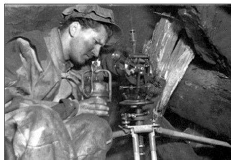
Jiří Duška si posvítí na teodolit, aby přečetl naměřené hodnoty.
