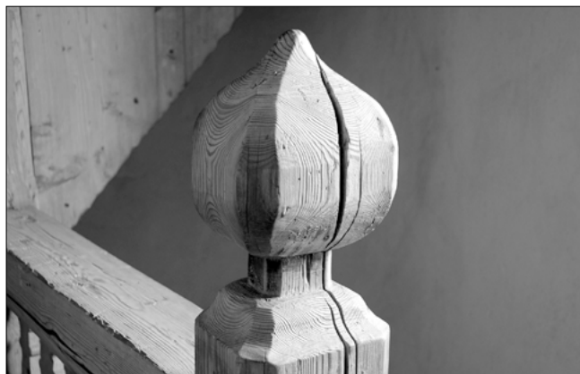
Detail zábradlí na kúru v kostele sv. Petra a Pavla.
