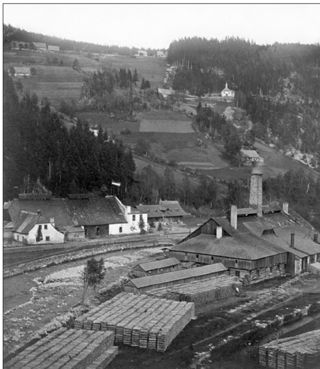
Iniciátorem povídání o sklárně byl Bertholdův prasynovec Wladimír Aichelburg, když redakci poskytl unikátní fotografii z roku 1874.
