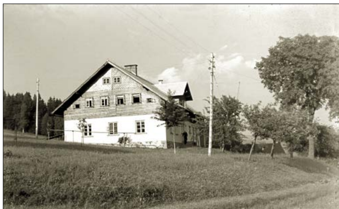
Dokončená novostavba ČH čp. 1 po požáru 1937.
