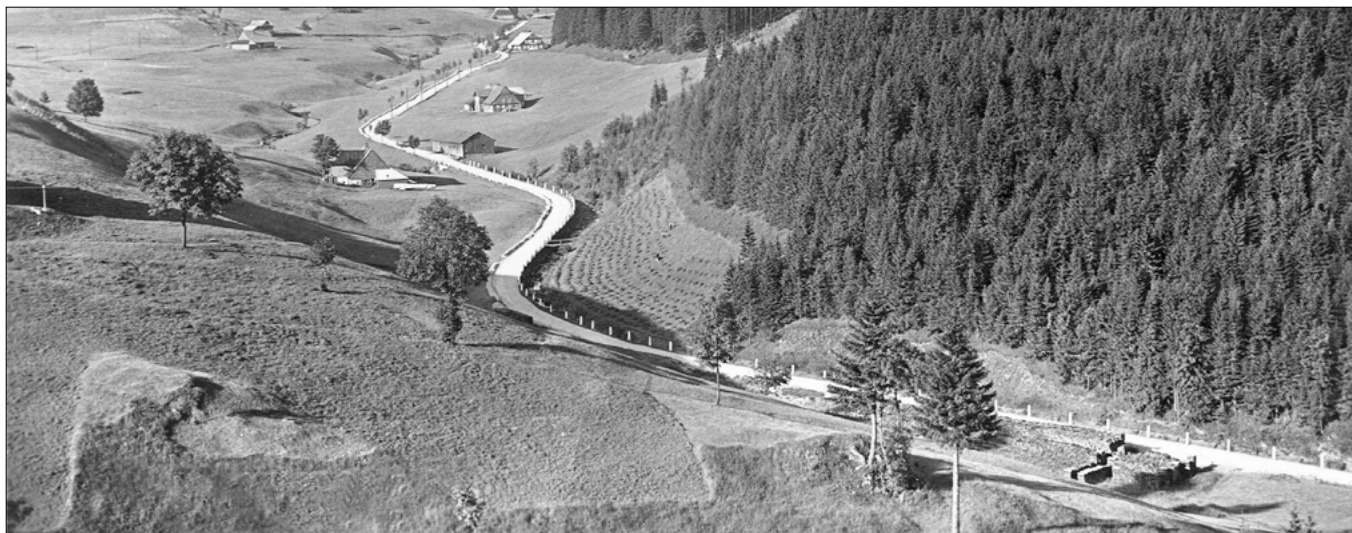
Osada Smrčí v Horní Malé Úpě na devadesát let staré fotografii vznikla v 16. století nad plavební přehradou Fichtigklause.
