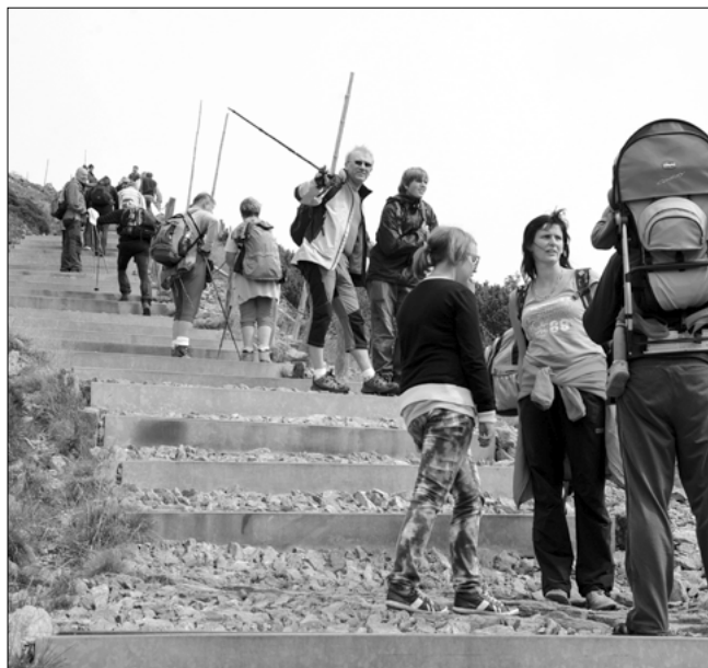
Na konci osmdesátých let byla cesta na Sněžku od Růžové hory jednou širokou erozní brázdou. Velká zátěž přinutila Správu KRNP po dvaadvaceti letech od zpevnění letos provést nové štětování kvalitním kamenem dopraveným nahoru vrtulníkem. Snížení nezbytných stupňů přispěje k pohodlnější chůzi turistů hlavně při sestupu.
