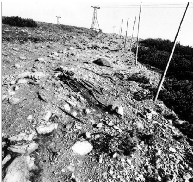
Na konci osmdesátých let byla cesta na Sněžku od Růžové hory jednou širokou erozní brázdou. Velká zátěž přinutila Správu KRNP po dvaadvaceti letech od zpevnění letos provést nové štětování kvalitním kamenem dopraveným nahoru vrtulníkem. Snížení nezbytných stupňů přispěje k pohodlnější chůzi turistů hlavně při sestupu.
