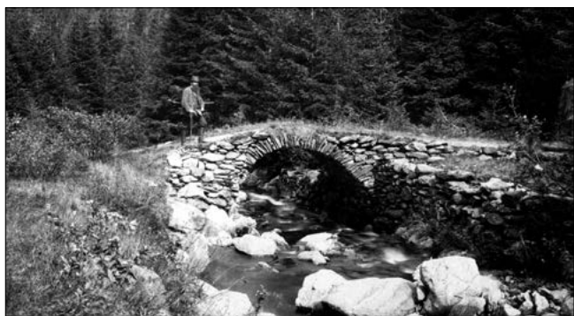
Mostek v Dlouhém dole ve Špindlerově Mlýně, 1900.
