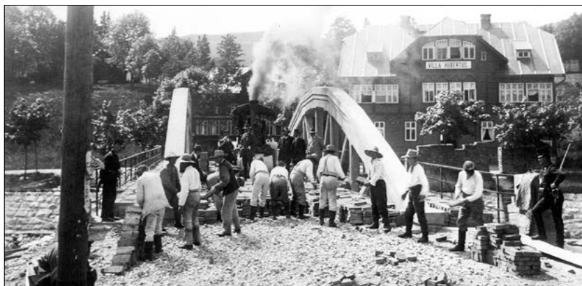
Parní válec na Bílém mostě ve Špindlerově Mlýně, 1911.
