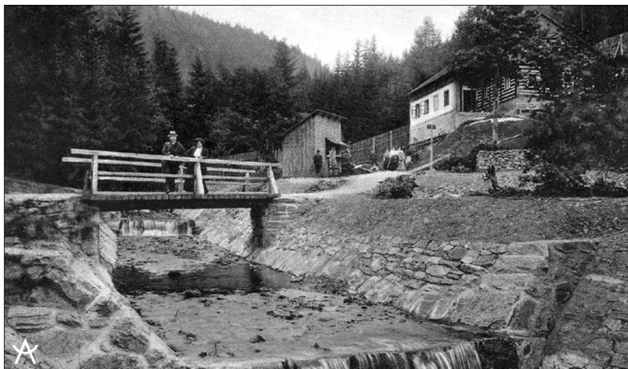
V budce na začátku Klausového dolu prodávali vstupenky, pohlednice a suvenýry, 1911.
